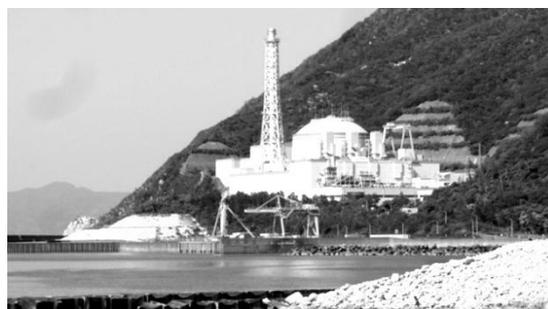
もんじゅ 日本原子力研究開発機構 2016年12月21日 廃炉決定。稼働日数は22年間で250日。高速増殖原型炉。
